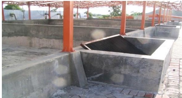
Gambar 2.1. 10 Unit Penerima Lumpur dari truk tinja, di IPLT Betyoguci, Gresik
